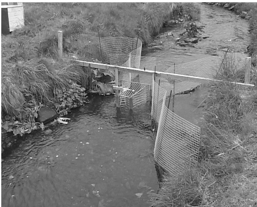
Figur 13. I Bleikelva på Andøya i Nordland er det mulig å telle oppvandrende fisk i hele elvetverrsnittet ved hjelp av en mekanisk fisketeller og undervannsvideokamera. Elva er bare tre meter bred på det aktuelle stedet.
