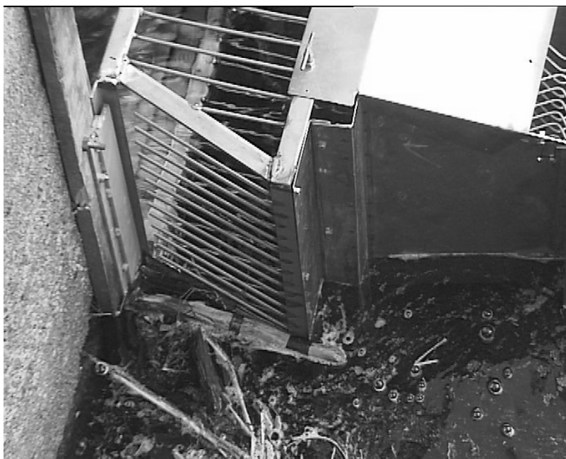
Figur 3. Spilene som slipper vann igjennom utenom "dørene" i den mekaniske telleren, er avsluttet før de når festeramma til betongen. Dette gjør at mesteparten av drivende blader og kvister ikke stuves opp, men slipper ned fisketrappa.
