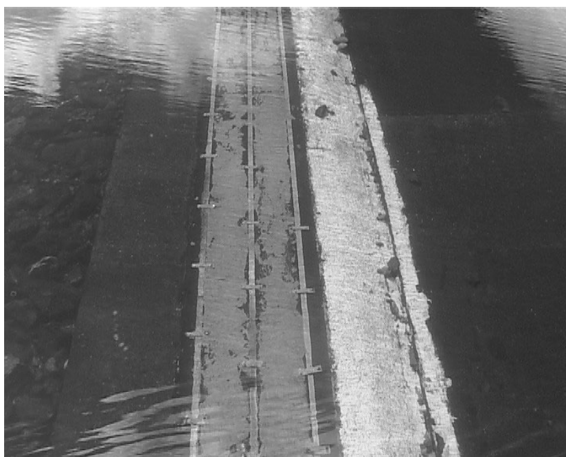
Figur 6. Elektrodene på bunnen ved terskelen på Bjørsetdammen i Orkla. Tre flatjernsprofiler i rustfritt stål er festet på en betongsåle. Fisken passerer fra høyre mot venstre i bildet.
