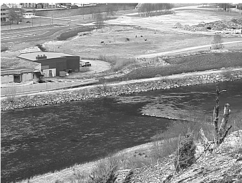
Figur 11. Terskelen i Lærdalselva ved Villakssenteret i Lærdal er ca 52 meter brei og 1,5 m dyp. Fire undervannsvideokamera i 2000 og åtte i 2001 var plassert etter hverandre over tverrsnittet.
