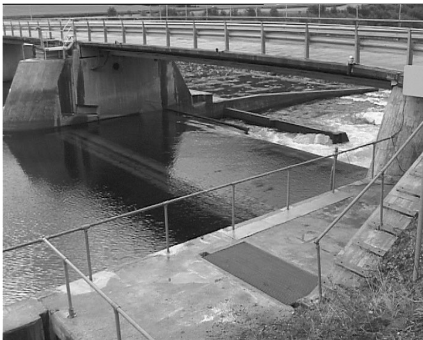
Figur 5. Bjørsetdammen i Orkla i Sør Trøndelag med konduktivitetsteller av typen Logie. Registreringstverrsnittet er 20 meter bredt og ca 1,5 m dypt.
